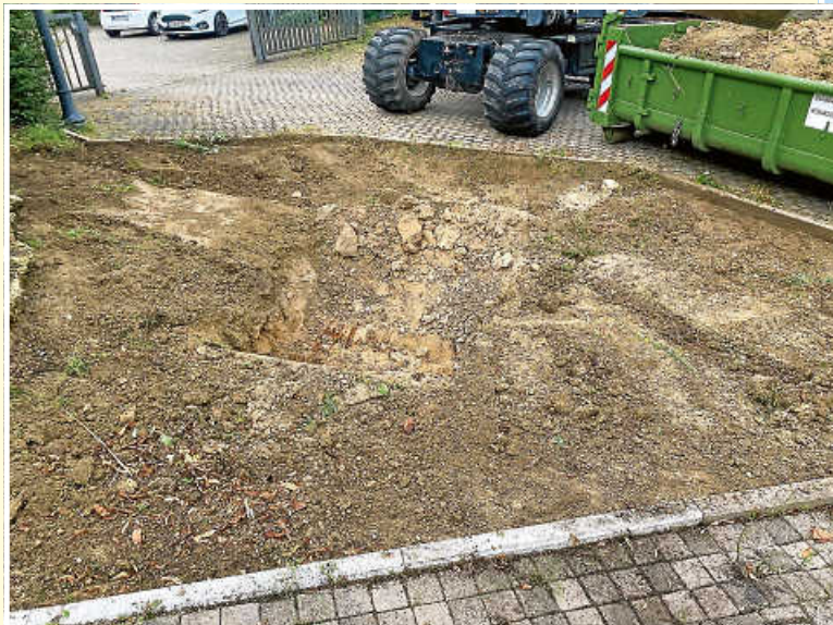
Zunächst wurde die Grube ausgehoben ...
