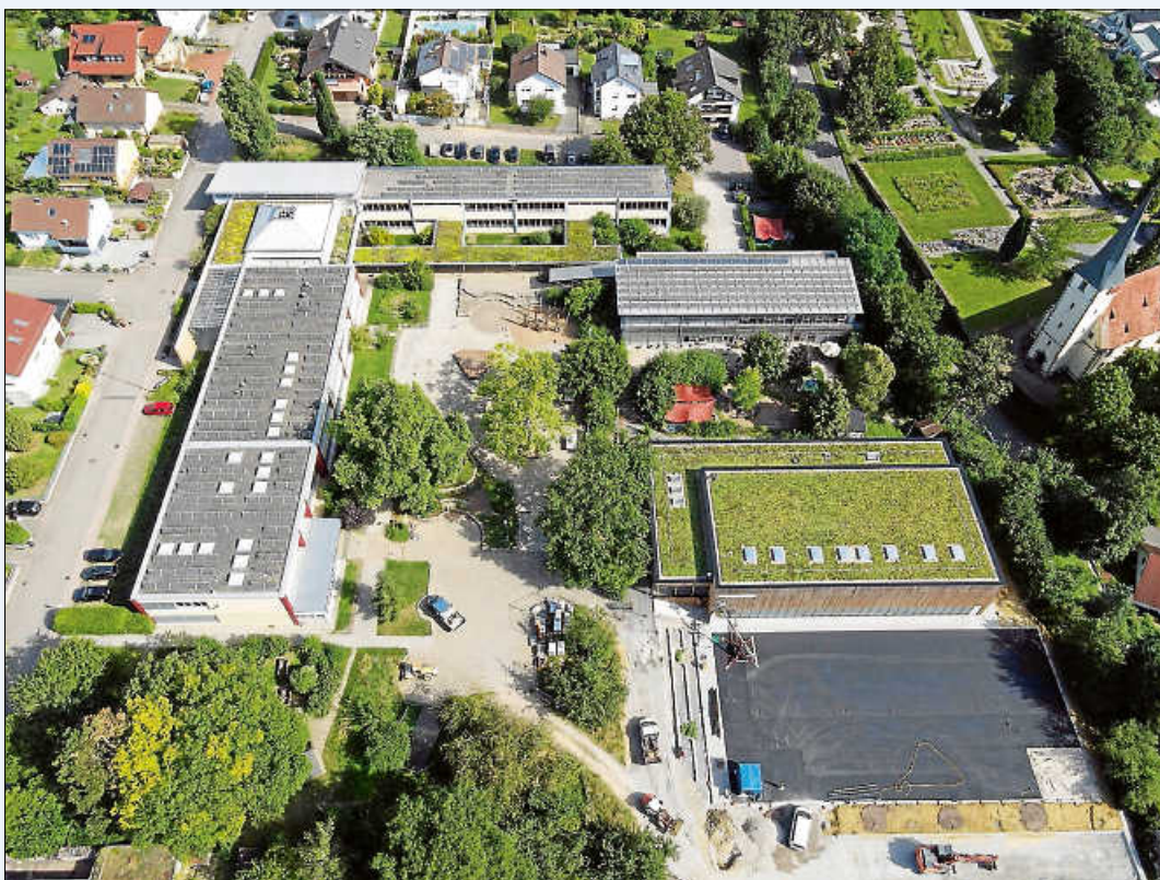
Bau des Kleinspielfeldes
