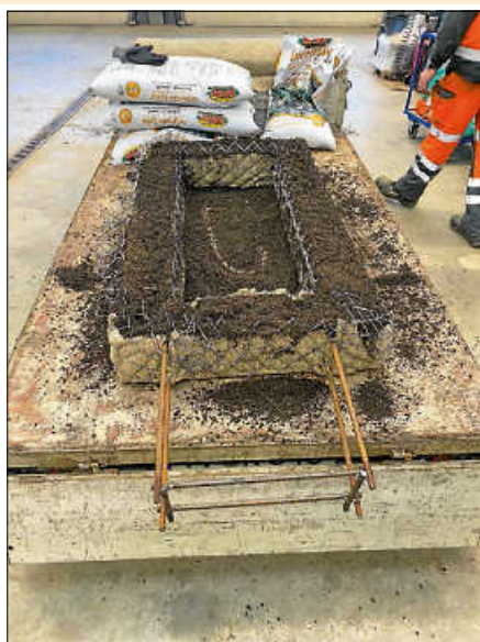
... danach mit Erde befüllt ...
