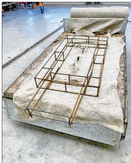
Der fertige Rahmen wurde zunächst mit Vlies überzogen ...
