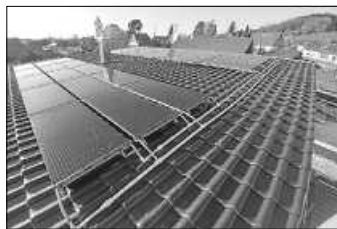
Ein Hybridmodul (PVT-Modul) vereint Photovoltaik-Technik mit Solarthermie (unterhalb der PV-Module angebracht). Foto: Consolar
